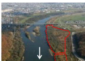
・河道掘削や樹木伐採
