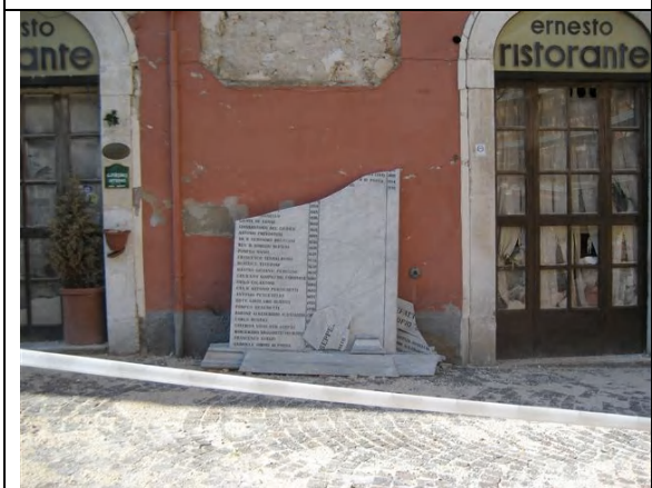
写真 落下した大理石碑（立入禁止地区）
