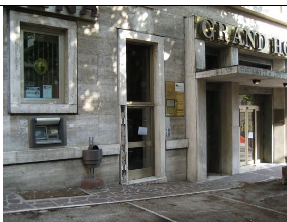
写真 扉の枠の破損 (立入禁止地区)
