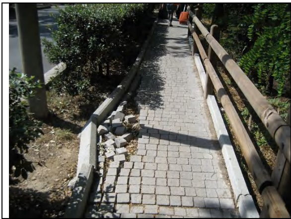
写真 ブロック道路の破損
