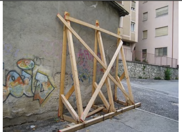
写真 傾いた壁の補修
