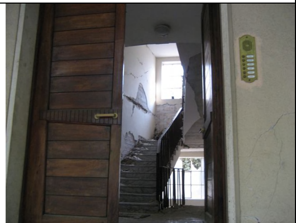
写真 家屋内の破損状況
