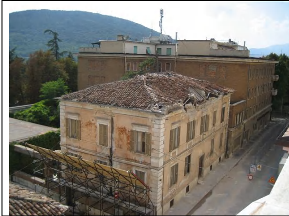
写真 屋根瓦の落下
