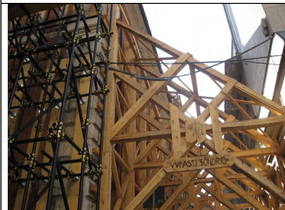
写真 傾いた家屋の補修（立入禁止地区）
