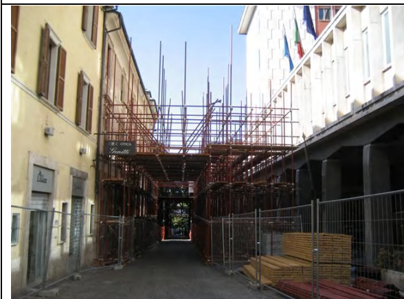
写真 修復のための足場（立入禁止地区）
