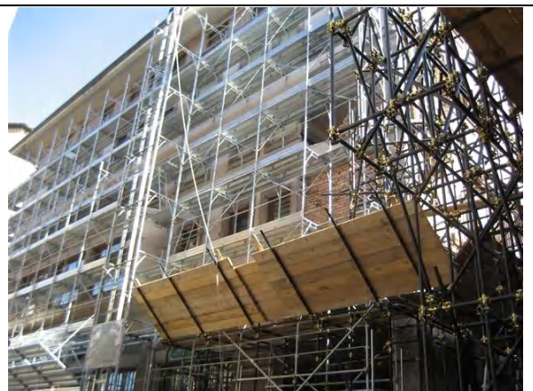
写真 修復作業中の家屋（立入禁止地区）
