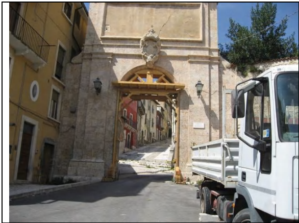
写真 旧市街地入口の扉の破損
