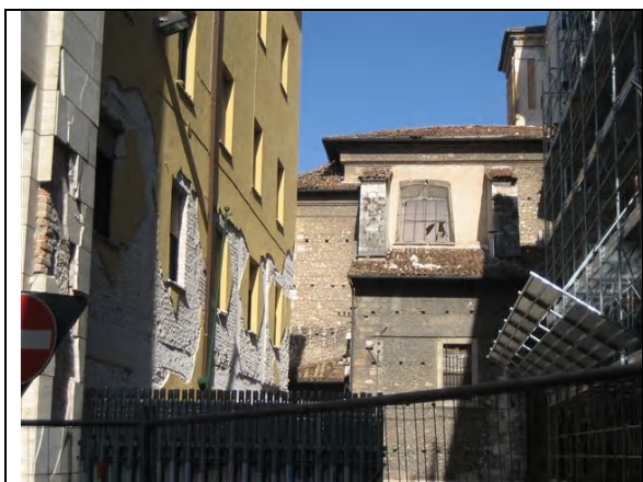
写真 割れたままの窓ガラス (写真奥)
