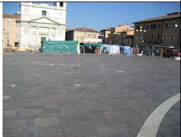
写真 聖堂前広場の床の破損状況
