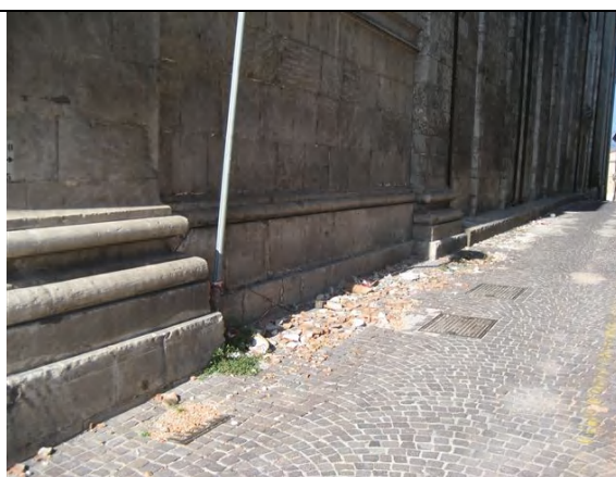
写真 壁の部分的崩壊 (立入禁止地区)
