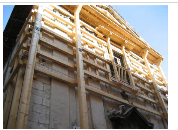
写真 崩れそうな家屋の補修（立入禁止地区）
