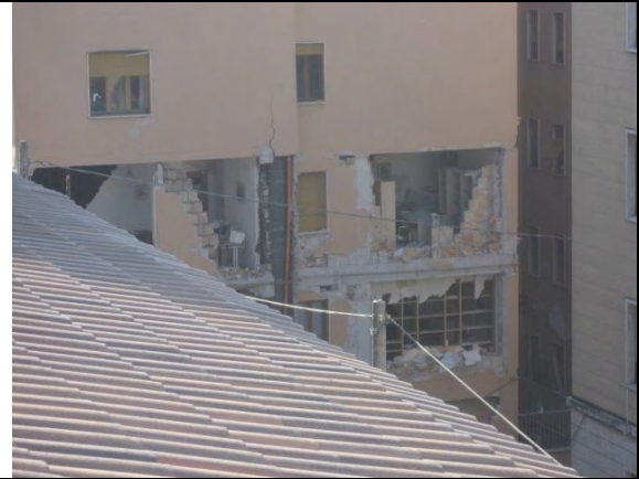
写真 壁の破損
