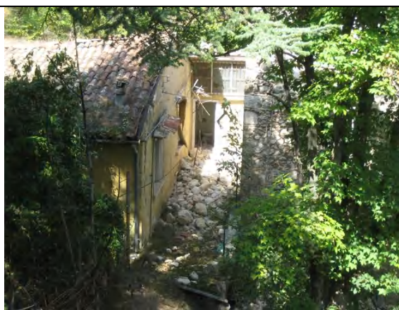
写真 壁の崩壊 (右手)
