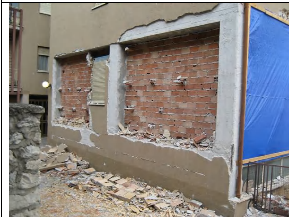
写真 壁の破損
