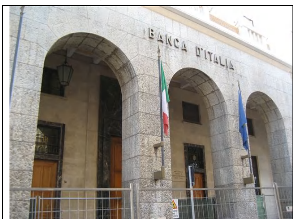
写真 破損の様子がみられない銀行
