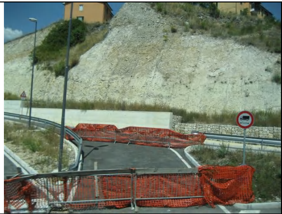
写真 崩れたと思われる道路の壁
