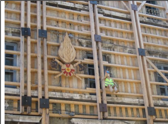
写真 修復状況と消防隊隊章（立入禁止地区）
