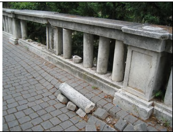
写真 ブロック道路と手すりの破損
