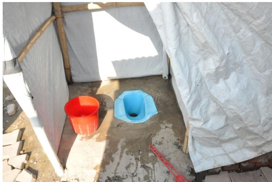
仮設トイレ(汚水は屋外のピットに貯まる)
