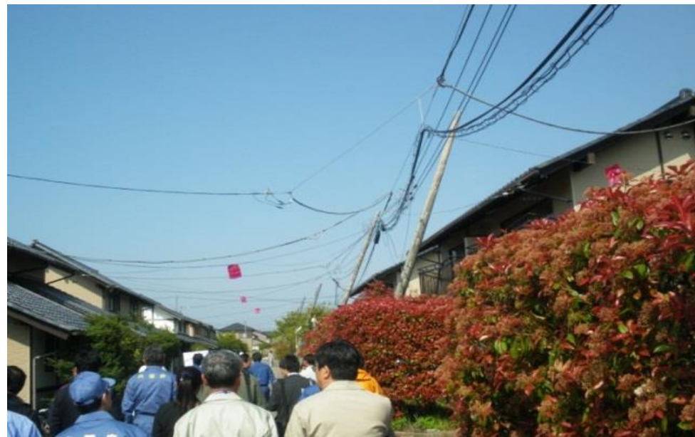
電柱の傾斜(茨城県潮来市) 内閣府撮影
