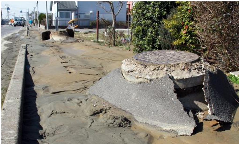
マンホールの浮き上がり(千葉県香取市) 香取市HP
