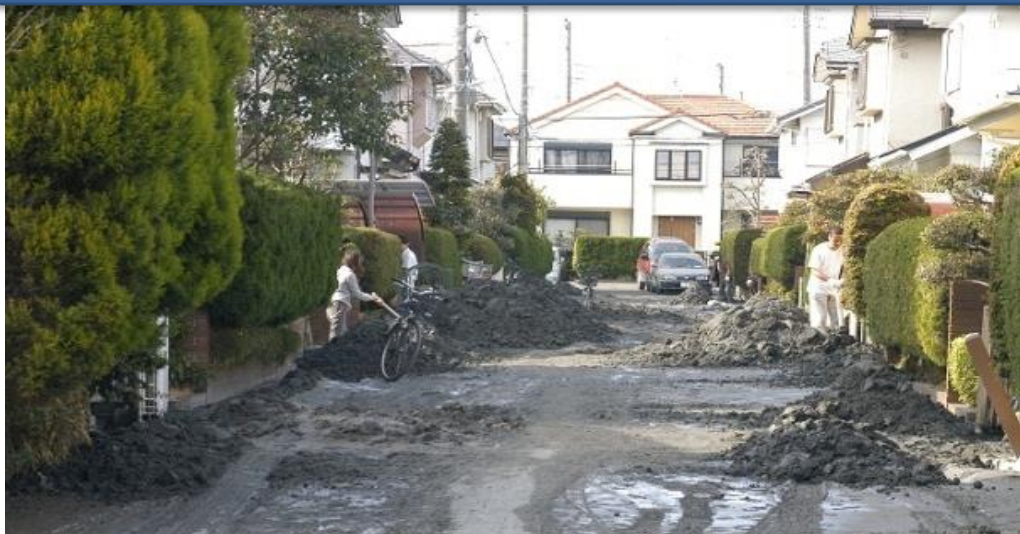
液状化による噴砂(千葉県浦安市) 浦安市提供
